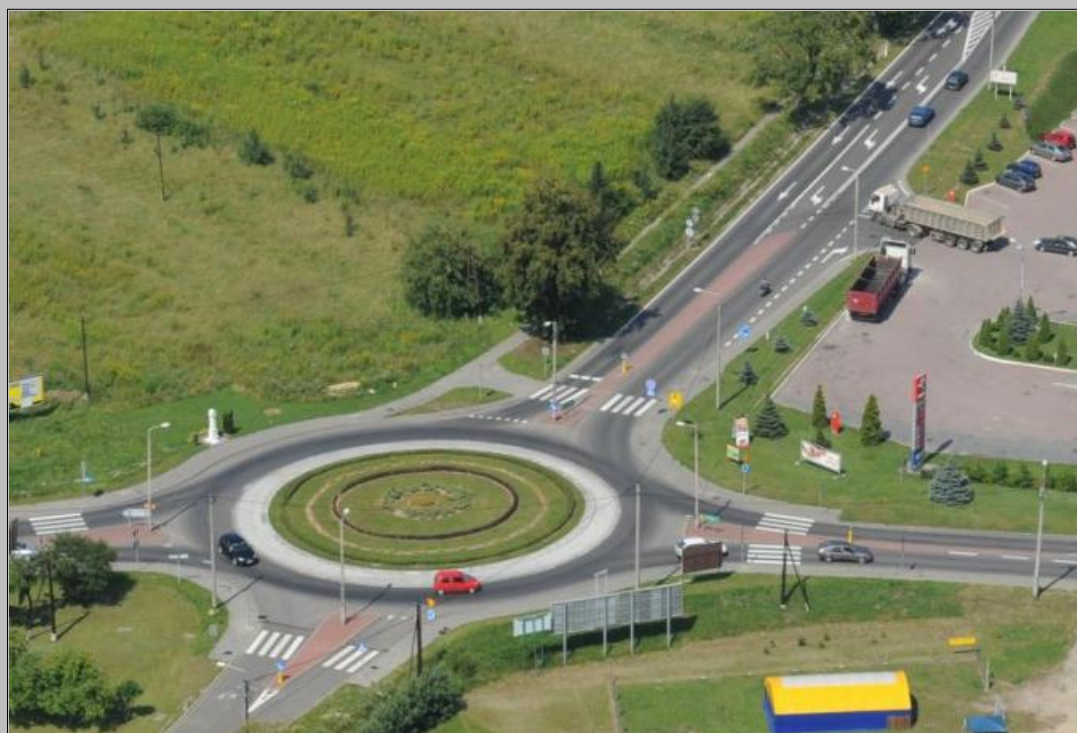
Fot. 2. Rondo na skrzyżowaniu drogi wojewódzkiej 933 Chrzanów-Oświęcim-Brzeszcze z drogą wojewódzką 780 Kraków-Chełmek
