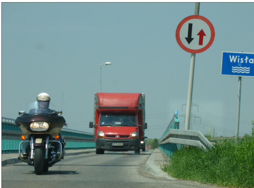
Fot. 11. Most na Wiśle o ograniczonej nośności na trasie łączącej strefę aktywności gospodarczej w Nowym Brzesku z budowaną autostradą A4
