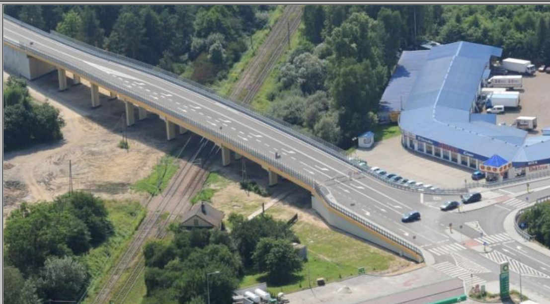
Fot. 1. Wiadukt kolejowy w ciągu drogi wojewódzkiej 933 Chrzanów-Oświęcim-Brzeszcze nad linią kolejową Trzebinia-Oświęcim
