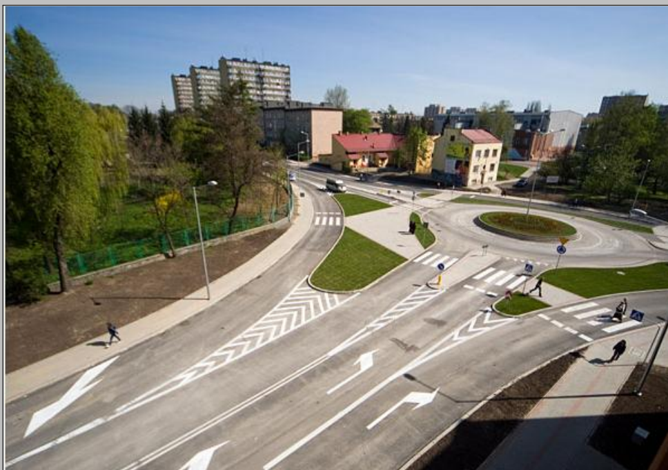
Fot. 3. Budowa połączenia autostrady A4 (węzeł Krzyż) z drogą wojewódzką nr 977
