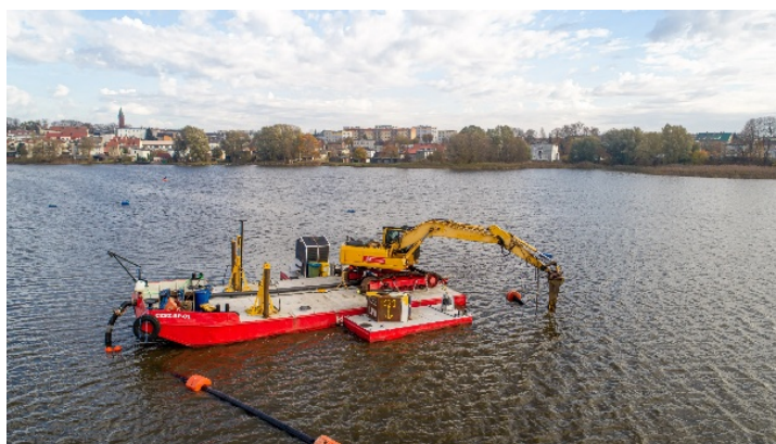
Rysunek 18. Usuwanie osadów dennych z jeziora Karczemnego.
